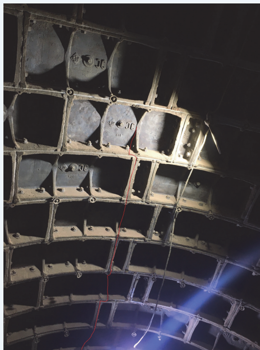
Рис. 3. Чугунная обделка наклонного хода
