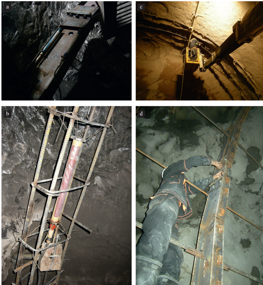
Рис. 5. Датчики ПЛДС-400, установленные на стальной двутавровой арке (а) и датчики ПЛДС-400, установленные в арматурную арку (б). Процесс установки датчиков в арматурную арку (с), процесс установки датчиков на стальную двутавровую арку (д) перед бетонированием
