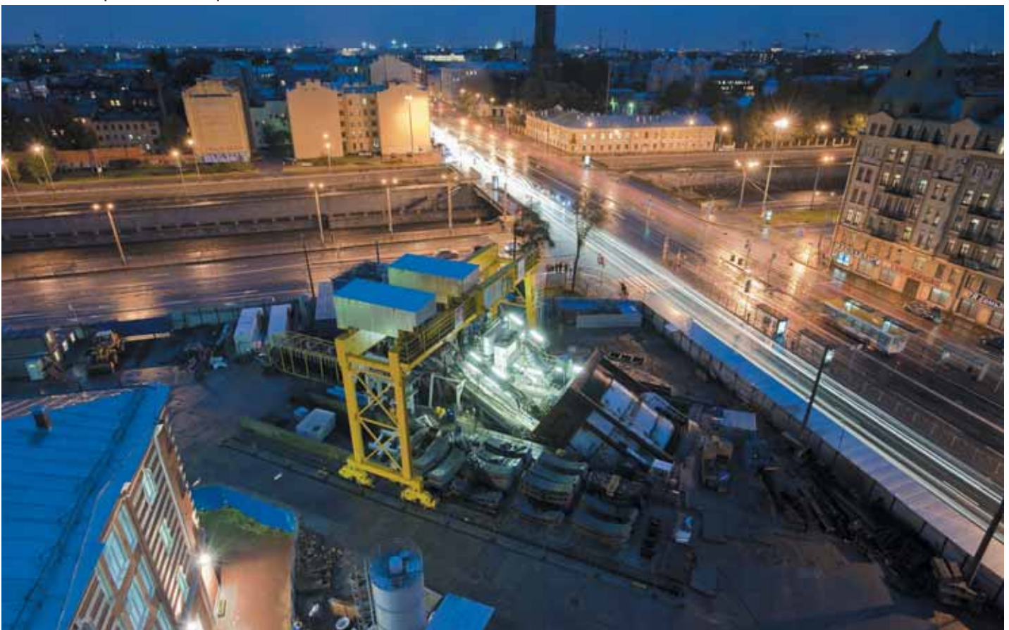
Рис. 6. Начало проходки эскалаторного тоннеля станции «Обводный канал»
