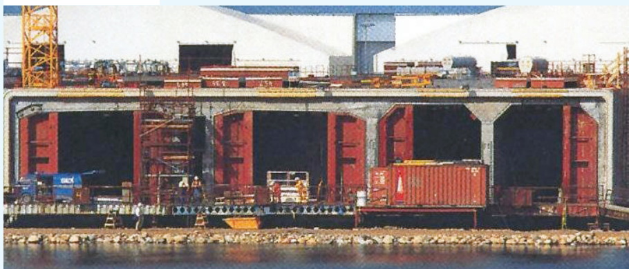
Рис. 2. Подготовка секции тоннеля к транспортировке
