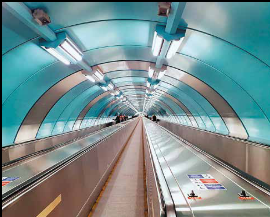
Рис. 12, 13. Композитные водоотводные зонты на ст. «Спортивная»
