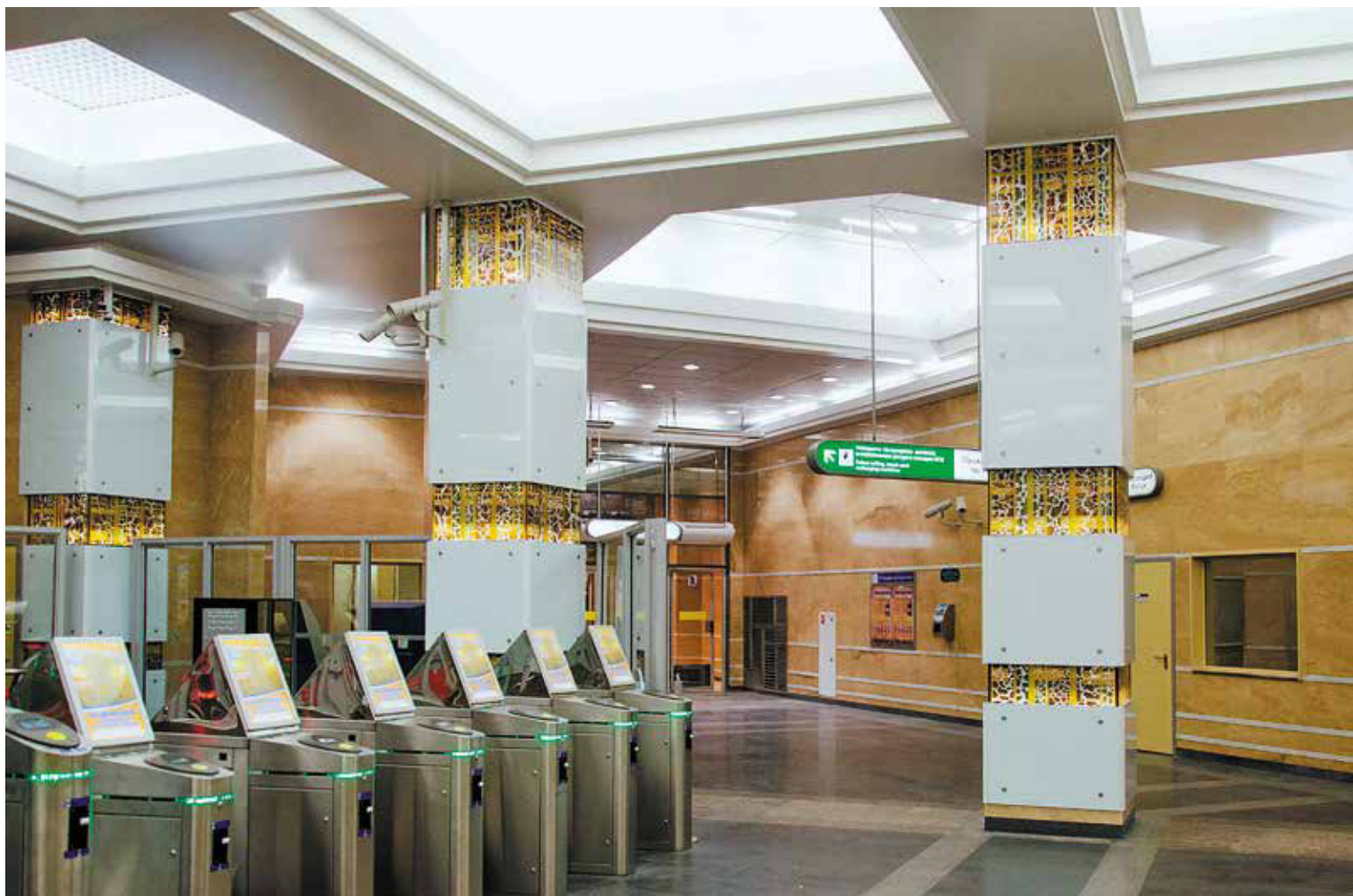
Рис. 5. Вестибюль ст. «Спасская». Фрагмент интерьера
