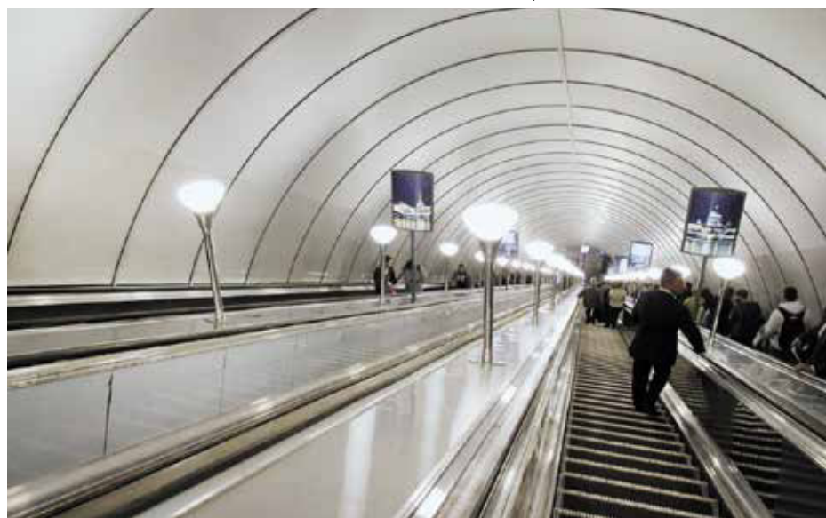
Рис. 11. Композитные водоотводные зонты на ст. «Обводный канал»
