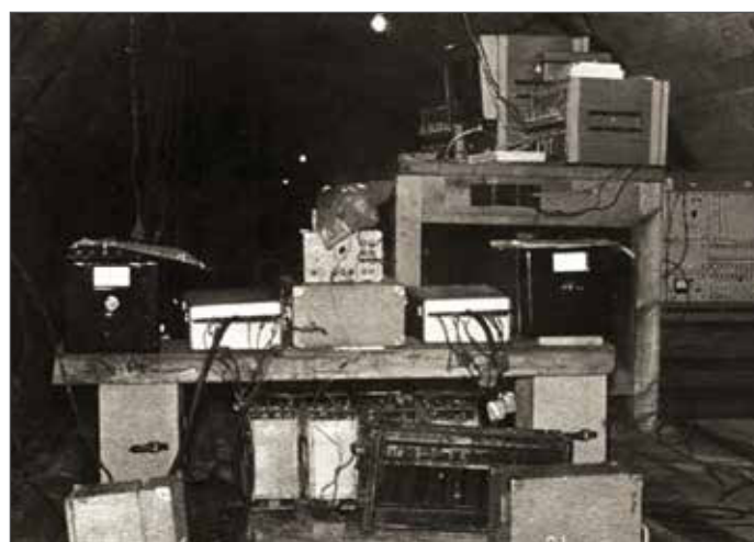
Рис. 6. Аппаратура подземной сейсмической станции во вспомогательной (дренажной) штольне со стороны западного портала в зоне Ангараканской депрессии
