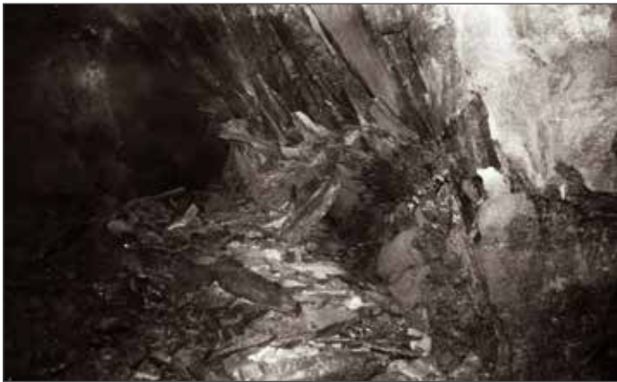
Рис. 3. Фотографии разрушений породы у сочленения выработок
