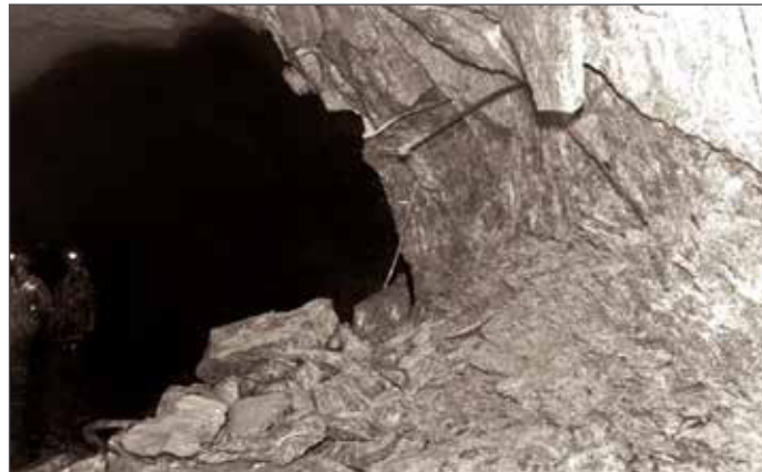
Рис. 3. Фотографии разрушений породы у сочленения выработок
