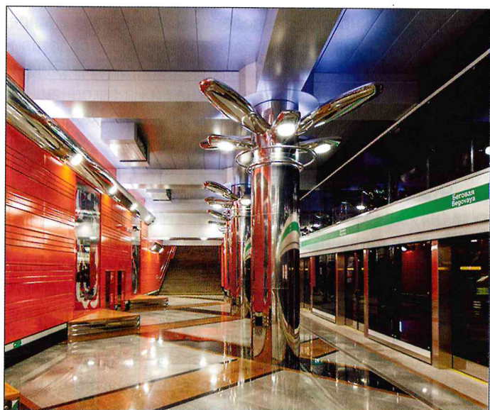
Рис. 4. Станция «Беговая». Платформенные двери
